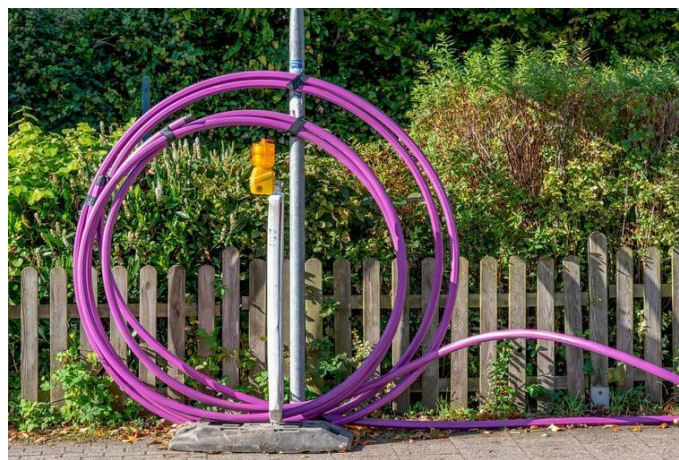
Hier wird Glasfaser verlegt, um für schnelleres Internet zu sorgen. Fotograf/-in: picture alliance / SULUPRESS.DE
